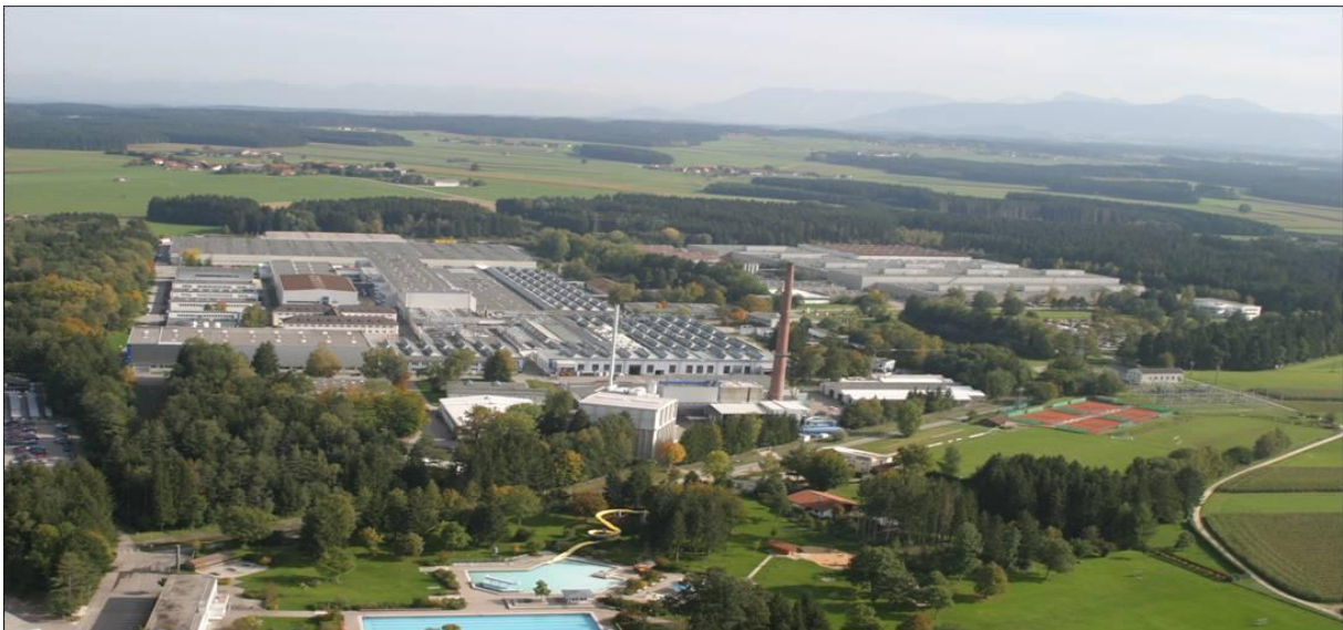
Standort Traunreut der BSH Hausgeräte GmbH
