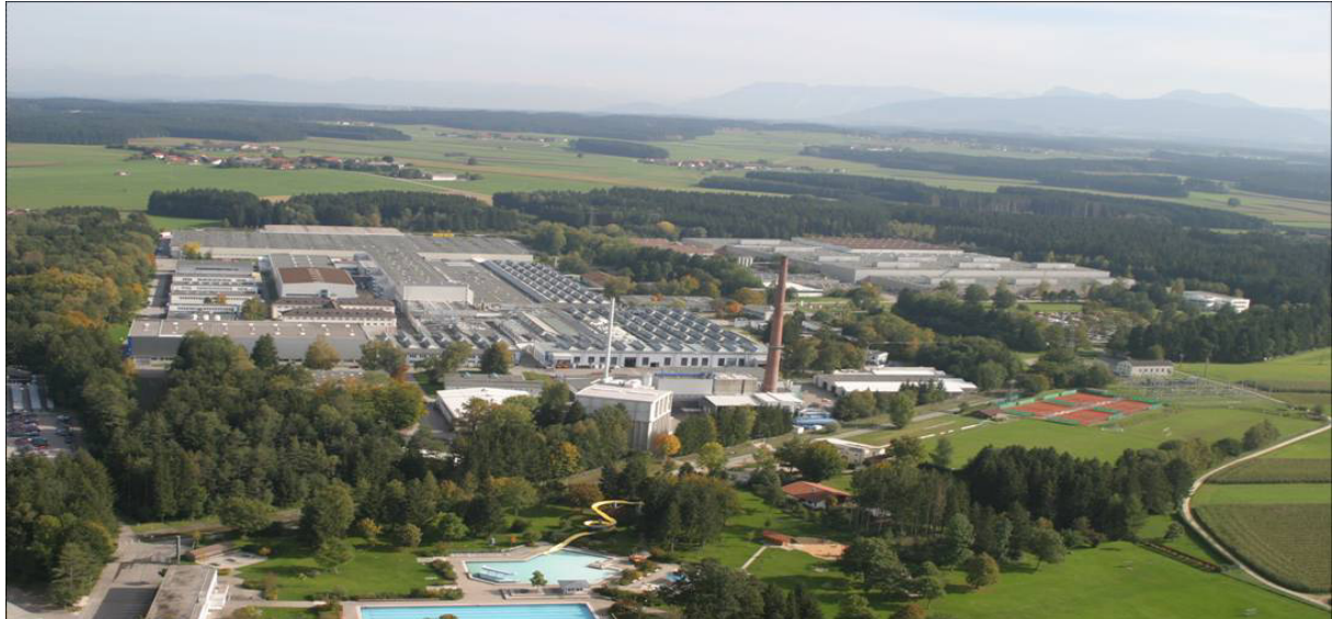
Standort Factory Cooking Traunreut (FCGT) der BSH Hausgeräte GmbH.
